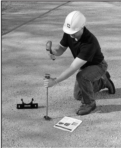
Placing Rante-Arrow - Step 4
